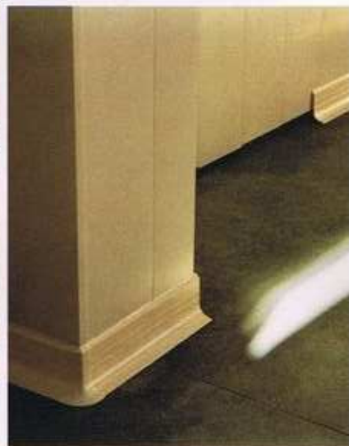
MONTAJE P.V.C. CON PERFIL SANITARIO
