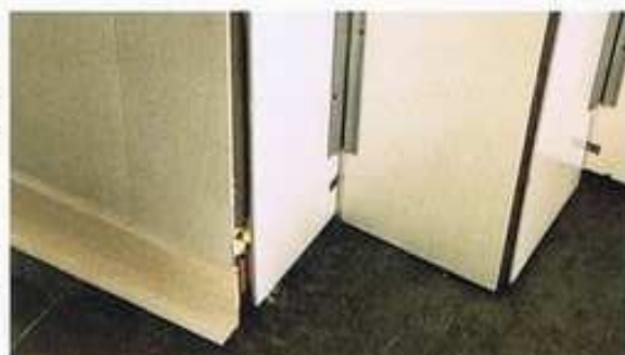
MONTAJE P.V.C. CON PERFIL SANITARIO
