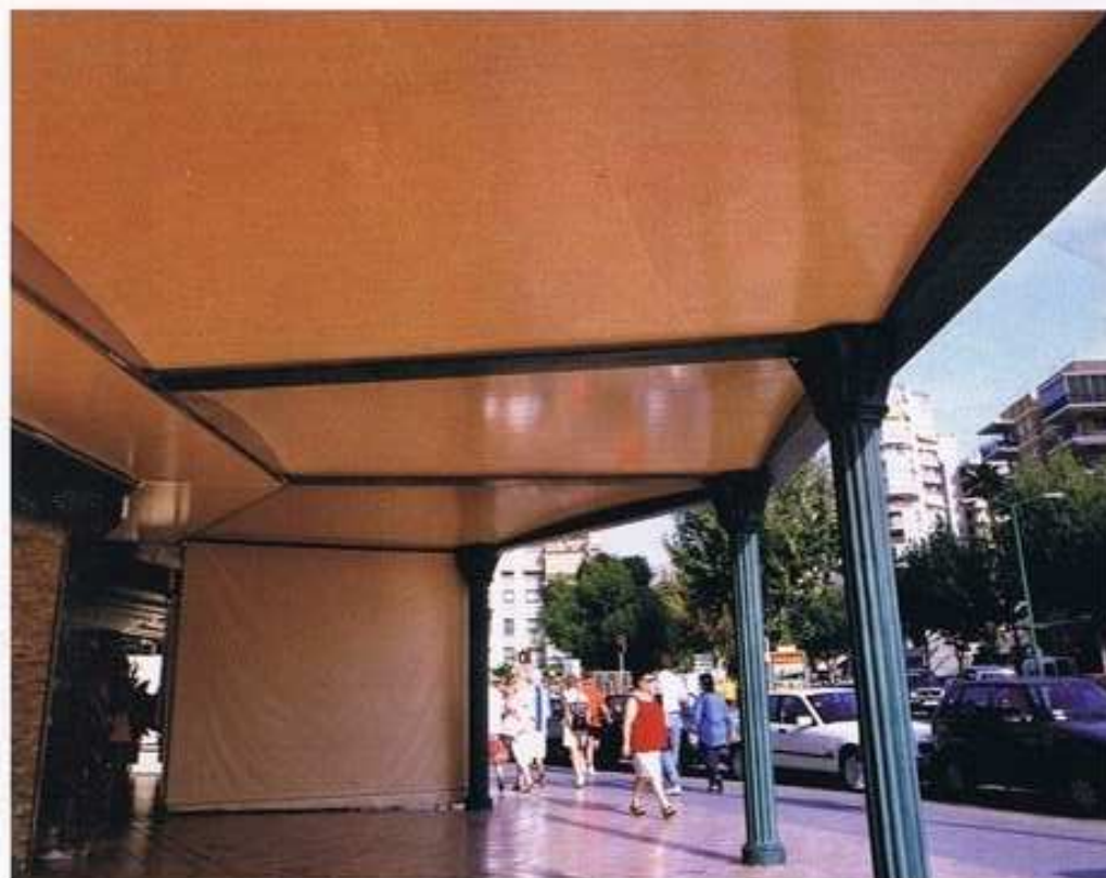
TECHO EN ZONA COMERCIAL
