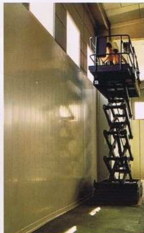
MONTAJE P.V.C. CON PERFIL SANITARIO
